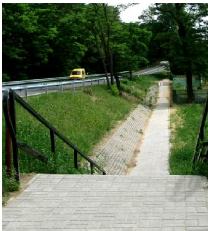
Chodnik w Karolewie – zakończony I etap budowy. II etap będzie realizowany także w 2006 roku w stronę Nowej Wsi. Inwestycja, która poza wymiernymi efektami daje ogromne poczucie bezpieczeństwa wszystkim mieszkańcom.
